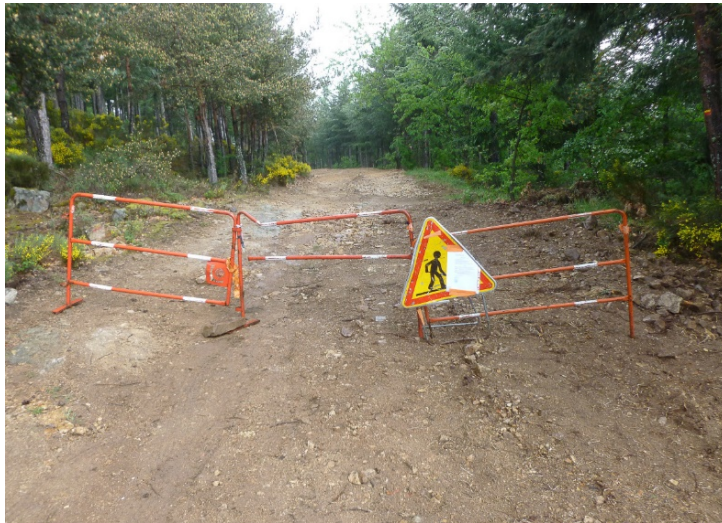
Rehabilitació d'un camí rural
